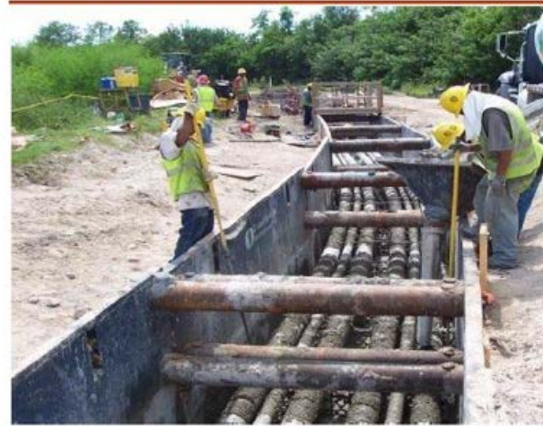
Figure 18-13 Conduit Placement
