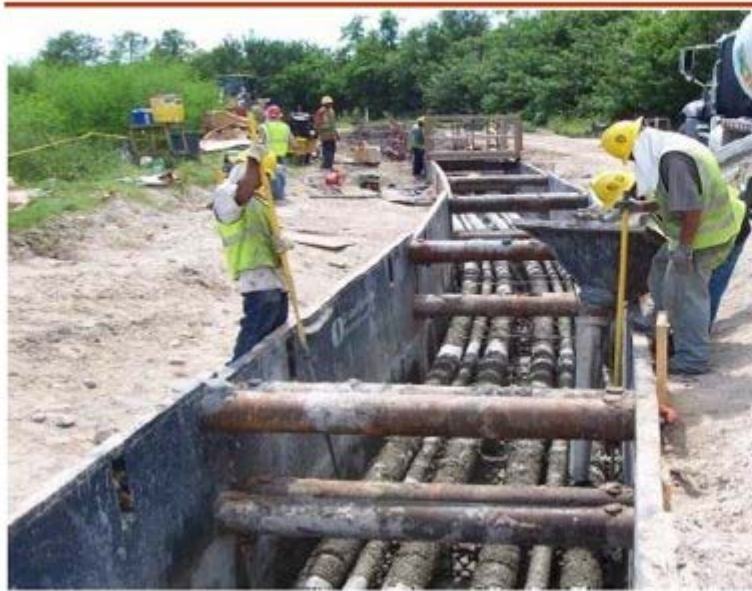
Figure 18-13 Conduit Placement
