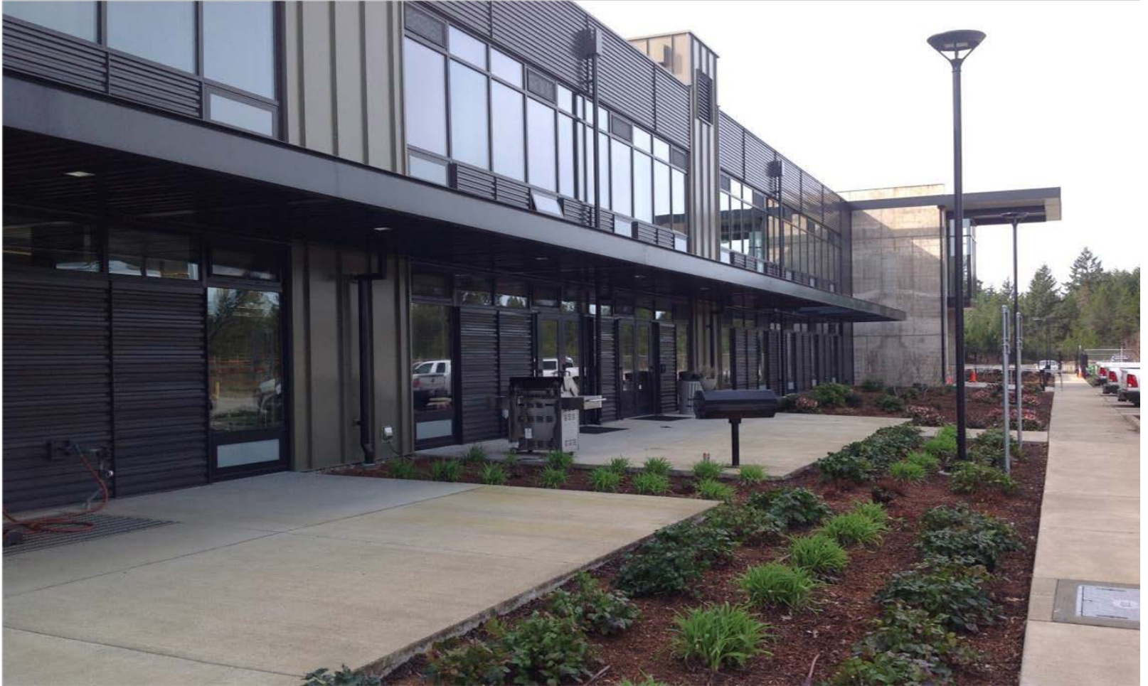
Mason PUD 3 Bull room / patio
